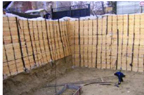
Рисунок 1.3 – Загальна схема горизонтального армування при будівництві котлованів
