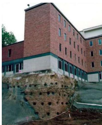
Рисунок 1.1 – Схема нагельного кріплення (а) та етапи його зведення (б-д)
