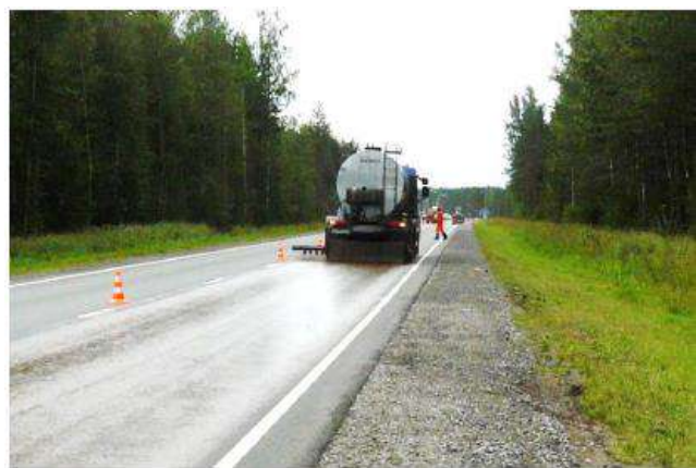
Рисунок 5 – Нанесення просочувального складу за допомогою автогудронатора
