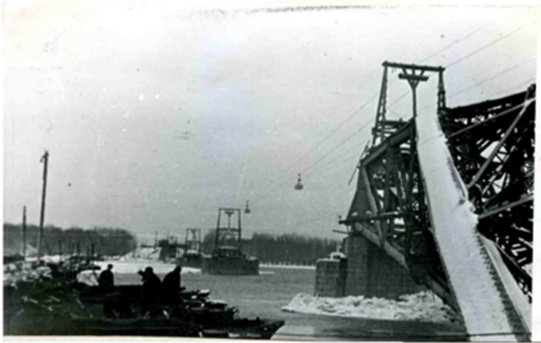
Канатно-підвісна дорога через р. Дунай у м. Байї. Вид з лівого на правий берег
