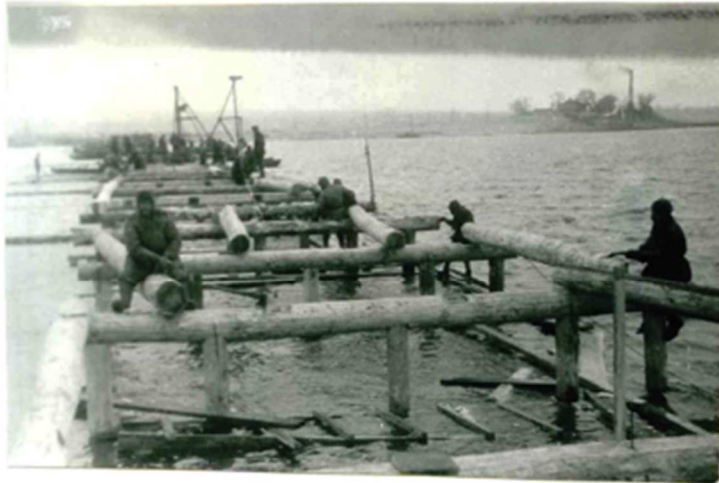
Будівництво берегових прольотів мосту біля м. Запоріжжя
