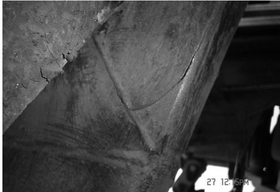
Рис. 7. Втомна тріщина каркасу основи кузова в задній частині
