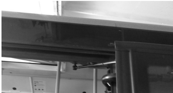
Рис. 2. Тріщина даху над передніми пасажирськими дверима
