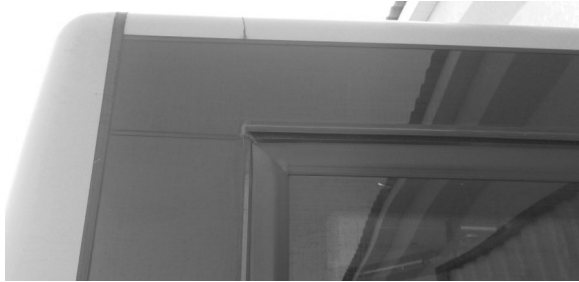
Рис. 1. Тріщина даху над задніми пасажирськими дверима
