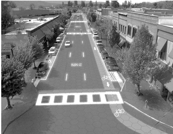
Рис. 2. Система, що складається з багатофункціональних панелей дорожнього покриття на певній частині дороги у населеному пункті
