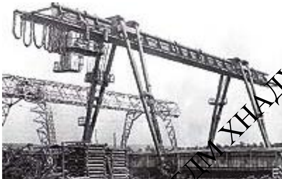
Рисунок 1.9. Козловий кран з гратчастим мостом
