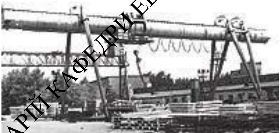
Рисунок 1.7. - Козловий кран із трубчастим перетином мосту
